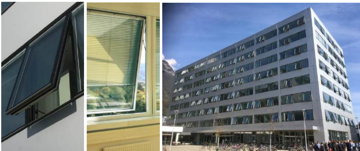
Abbildung 7: Modernisiertes Bauingenieur-Gebäude der Universität Innsbruck mit motorisch betriebenen Senkkipp-Fenstern für die Sommerlüftung (Fotos: PHI).
